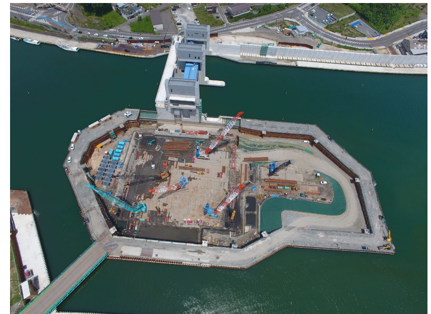
⑦ 二重締切内のドライワーク (岩手県県北広域振興局発注、二級河川閉井川筋藤原地区河川災害復旧(23災662号)水門土木工事、平成28年～令和2年、岩手県)
