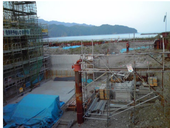
② 河口部でのドライワーク (岩手県釜石地方振興局発注、農地海岸下荒川地区第14号(水門土木)工事、平成21年～23年、岩手県)
