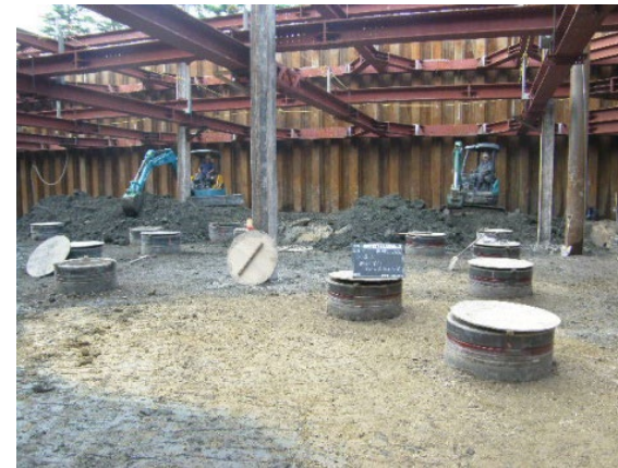
③ 盤ぶくれ対策、復水 (日本下水道事業団発注、市川市菅野下水処理場建設工事、平成25年、千葉県)
