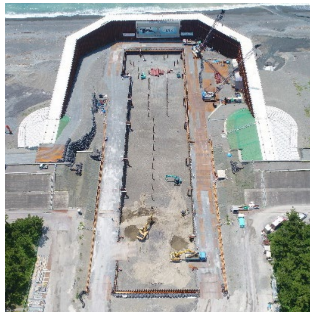
⑤ 開削工事のドライワーク (国土交通省中部地方整備局(静岡県)発注、沼川新放水路放流口、令和3年～4年、静岡県)
