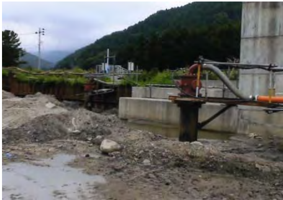
SWP揚水状況
