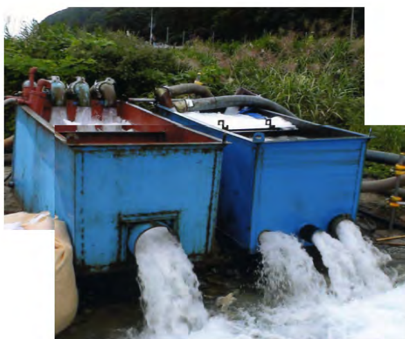
四角ゼキでの排水状況 注) 井戸 1 本当り排水量 4.0m 3 /min 以上
