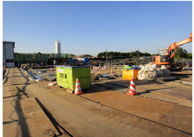
対象範囲の四隅に Qin-TAKO を設置
