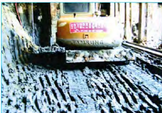
写真-5 掘削土改良状況
