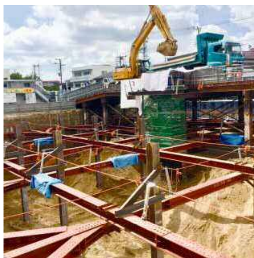
写真-1 掘削時の状況
