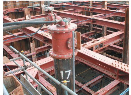
写真-2 井戸の設置状況(新潟市都市整備局下水道部下水道管理センター発注、下管第26号五十嵐2の町中継ポンプ場土木工事)
