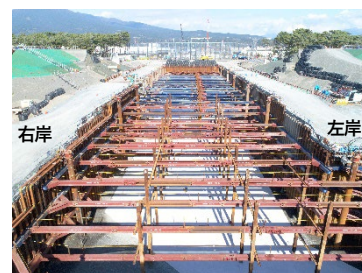
写真2 床付状況 (ドライワーク)
