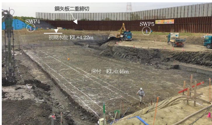
写真1 ドライワーク状況（五六川樋門床付時、地盤改良前）
