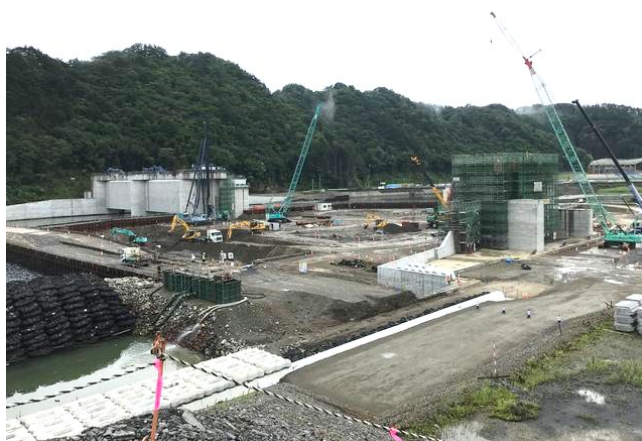
写真1 左岸2期の施工状況(岩手県HPより引用)
