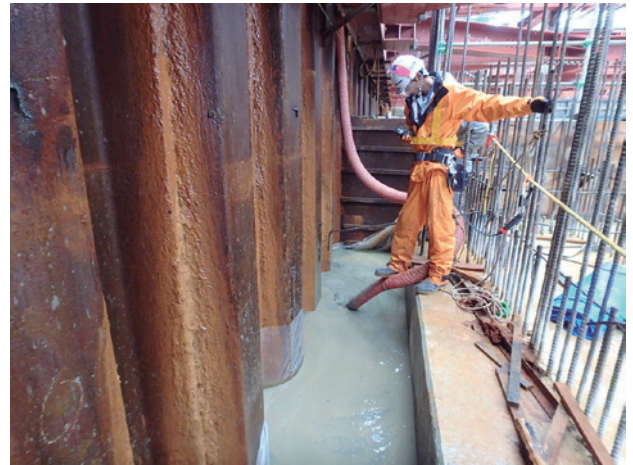
写真-2 流動化処理土打設状況
