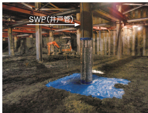
写真-2 SKK適用による掘削地盤面 (Ac1層)
