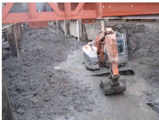
写真-1 無処理状態での掘削地盤面の状況
