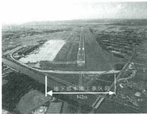
写真-1 施工区間の空中写真
