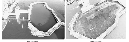
SWP工法による二重線切内の排水工事(岩手県宮古市閉伊川水門工事)
