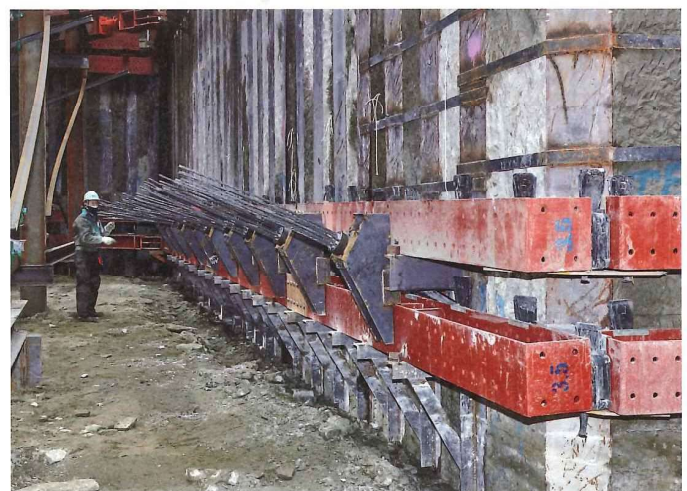
保存棟の荷重による山留め変位に対して計画したアースアンカー施工状況。 | Earth anchor planned against displacement of the earth-retaining due to the load of the preserved building.
