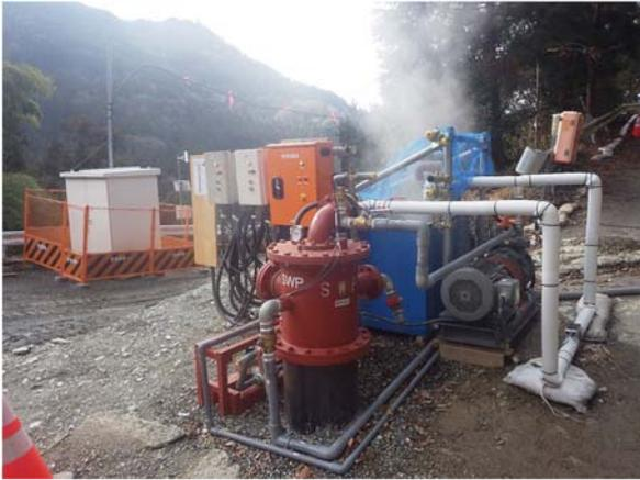
図-8 真空ポンプのみ稼働させている状況
