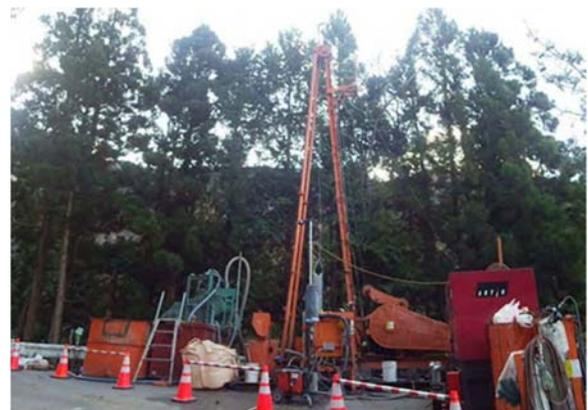
図-7 汲み上げ井戸の施工状況
