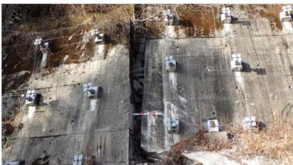
図-6 SWP 工法施工箇所周辺の構造物変状
