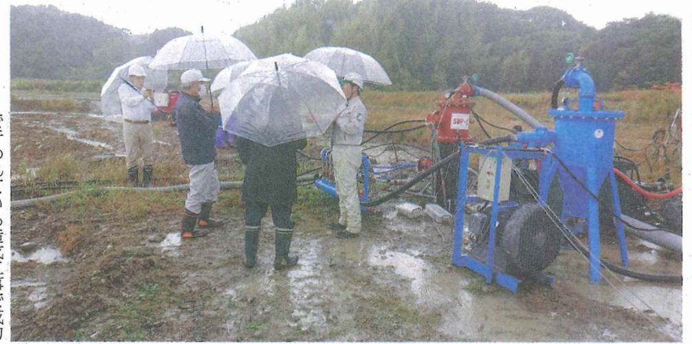
CVT工法の概観。稼働状況や沈下可視化、見通しなど説明を受ける。
