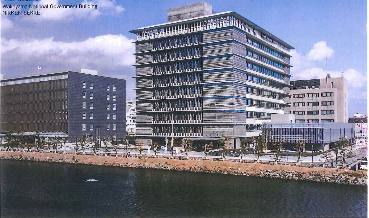
隣接する裁判所と外装デザインに共通性を持たせ、街区全体としての統一感を創出した
