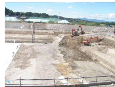
④ 開削工事のドライワーク（東京都下水道局発注、八王子水再生センター西系水処理施設建設工事、平成26年～29年）
