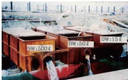
写真1: SWP工法とDW工法の揚水量の違い(信濃川沈埋トンネル工事)
