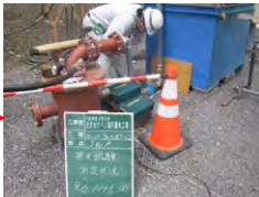
スーパーウェルポイント揚水試験 (流量計観測)
