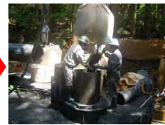
フィルター材(砂利)充填状況
