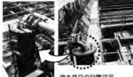
掘水井戸の設置状況
