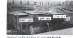
スーパーウェルポイントとディープウェルの揚水量の比較
