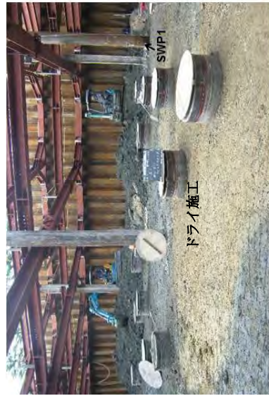
床付面掘削状況
