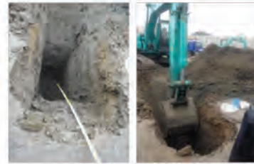
SKK工法による実証試験 (東京外環自動車道 田尻地区函渠その3工事)
