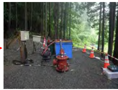
工事設備設置完了
