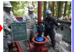
ポンプ・揚水管設置状況
