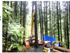
掘削状況(ダウンザーホールハンマー)
