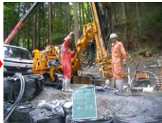
ロッド挿入状況
