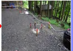
観測用ボーリング完了
