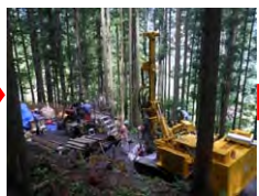
観測用ボーリング状況
