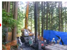
スクリーン管達込状況
