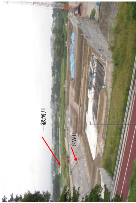
オープン掘削 ドライワーク(下水処理場)
