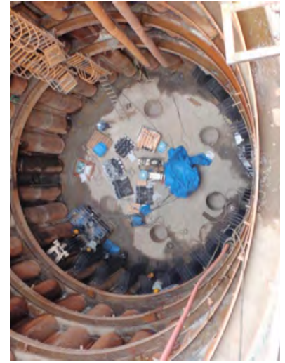
底盤コンクリート完了
