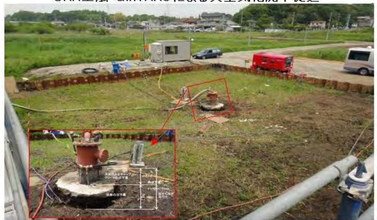
SKK工法+QinTAKOによる真空気化沈下促進
